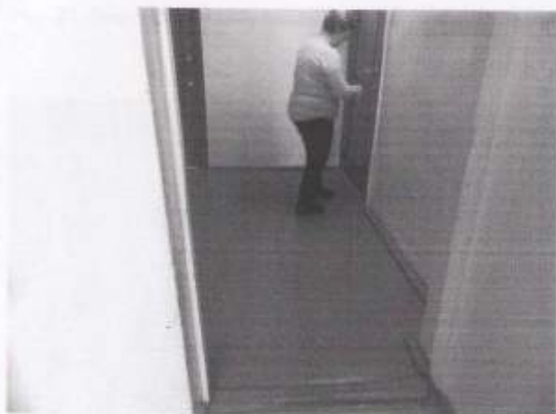
Рис. 18. Вход I в библиотеку, дверь – 0,90 м., порог – 0,02 м.
