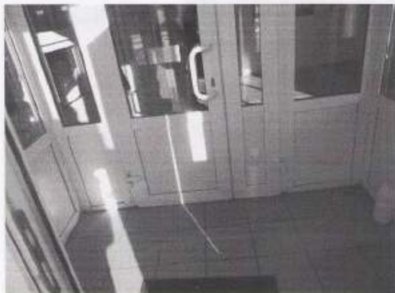
Рис.9. Тамбур. Входная дверь в вестибюль – 0,70+0,35 м.
