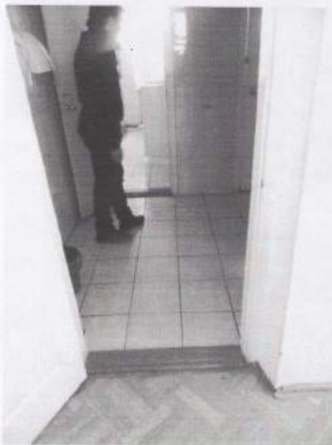
Рис. 26. Вход в туалет, дверь – 0,80 м, порог – 0,05 м.
