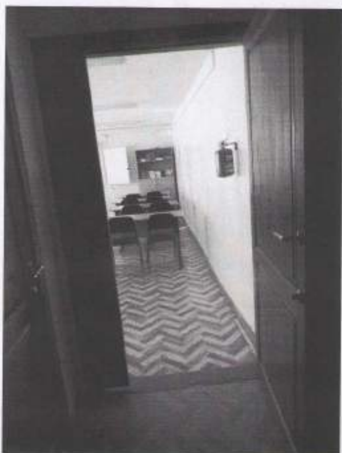
Рис. 16. Вход в аудиторию, дверь – 0,85+0,20 м., порог – 0,0 м.
