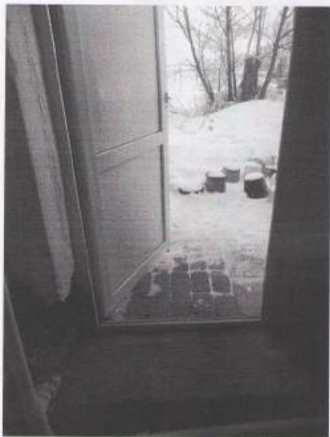
Рис. 25. Эвакуационный выход, порог – 0,17 м.
