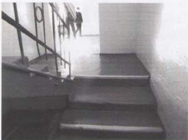
Рис. 21. Лестница к эвакуационному выходу.
