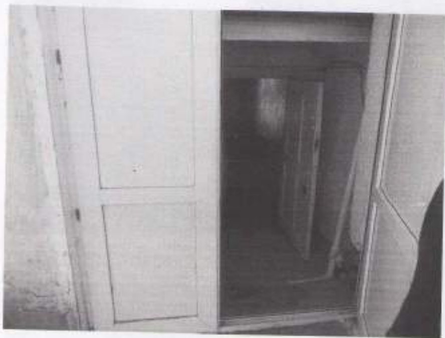
Рис. 24. Эвакуационный выход, дверь 2 – 0,83+0,70 м.
