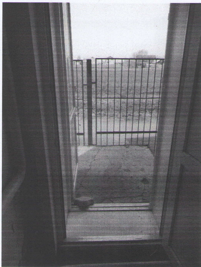
Рис. 20. Эвакуационный выход, дверь – 0,75 м., порог – 0,12 м.
