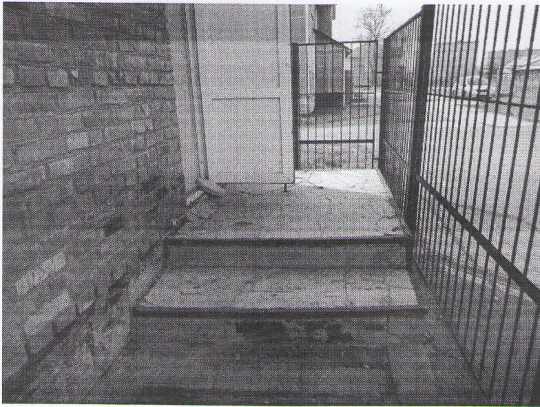
Рис. 21. Эвакуационный выход. Входная площадка.
