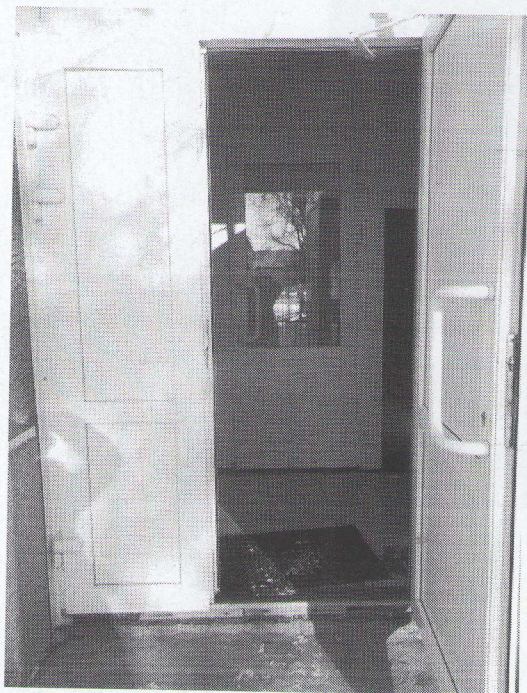
Рис.5. Входная дверь – 0,75+0,58 м., порог – 0,15 м.
