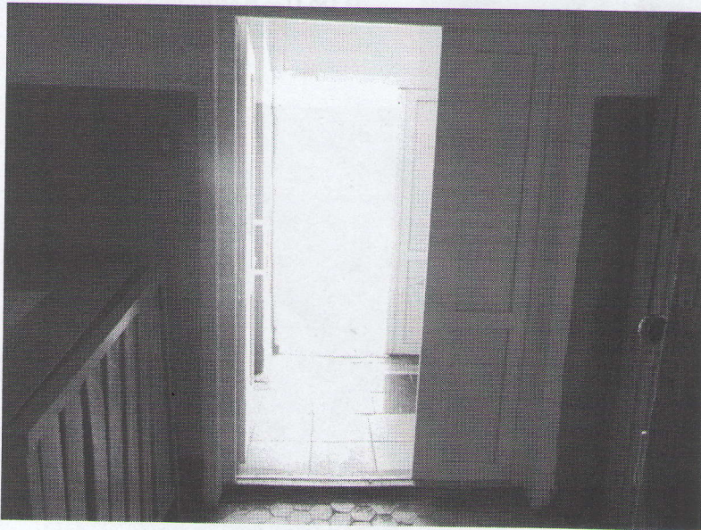
Рис.20. Эвакуационный выход. Дверь 2 -0,75+0,60 м, порог -0,05 м.
