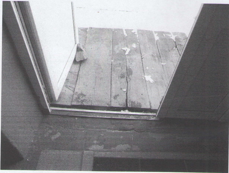
Рис.19. Эвакуационный выход. Дверь -0,75+0,60 м, порог -0,015 м.
