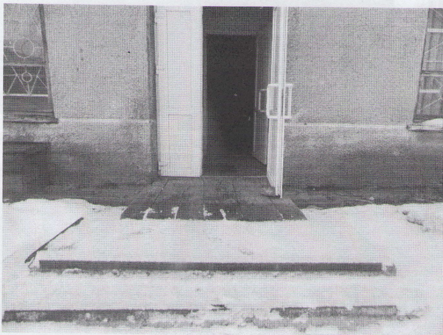
Рис.18. Эвакуационный выход. Лестница.
