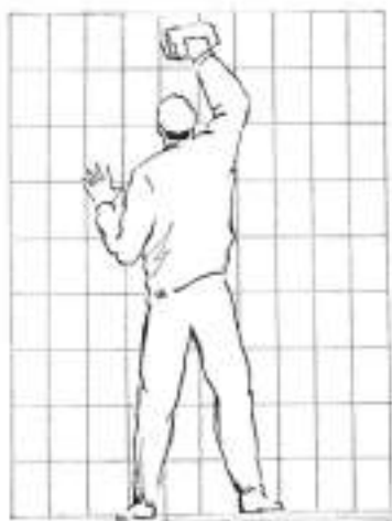
Рис. 3. Заполнение швов раствором и очистка
